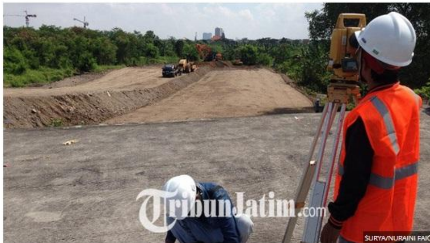
Para pekerja saat mengecek lahan MERR di Gununganyar Surabaya yang akan dikerjakan pembangunannya, Selasa (1/5/2018).
