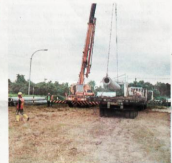
BANGUN JEMBATAN: Beton pancang untuk pembangunan JLLT seksi II tiba kemarin.
